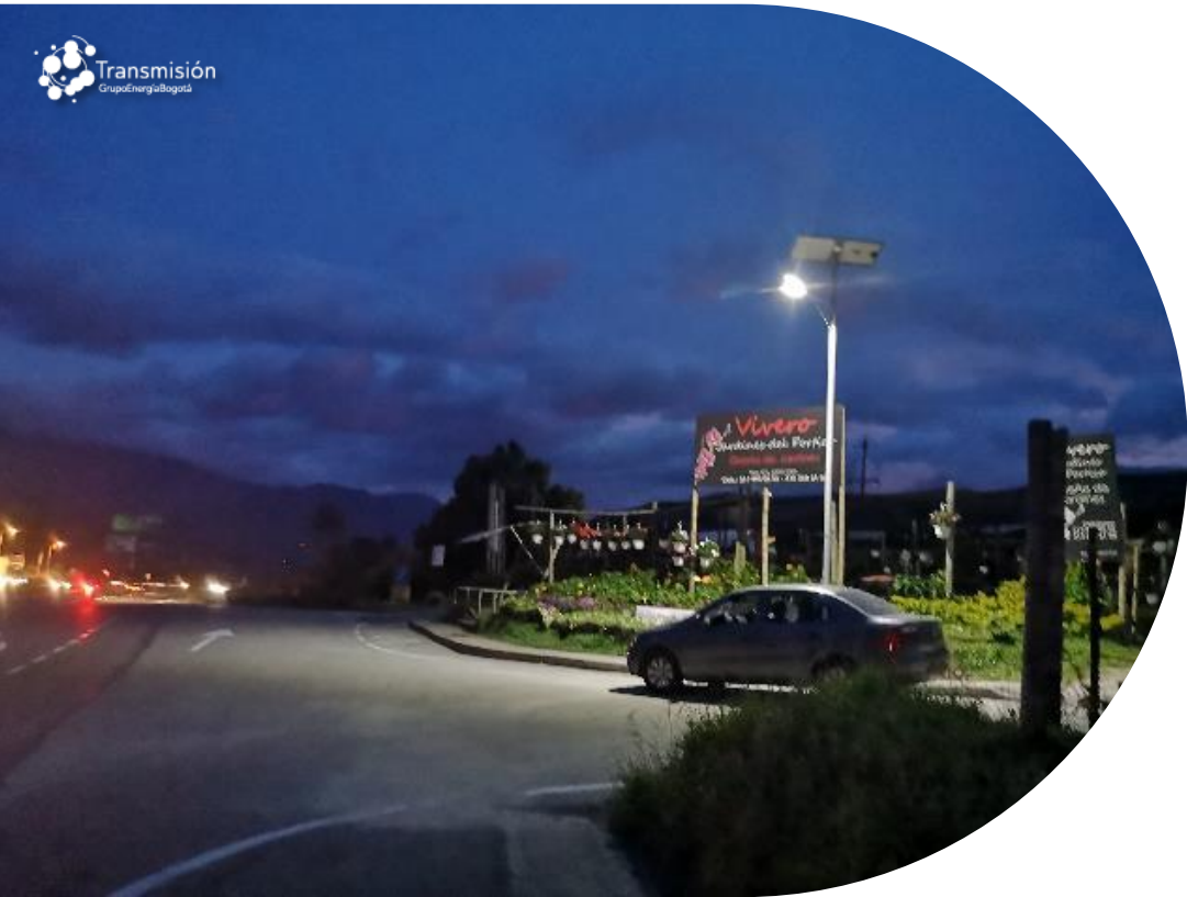
Paneles solares alumbrado público Circasia, Quindío
